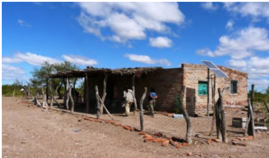
Figura 5. Paneles solares del programa PERMER en puesto de La Puntilla
